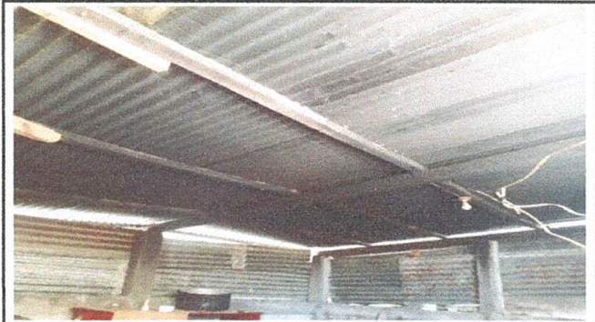
Foto 1: Condiciones del techo actual de la cocina, en la cual se hará la sustitución, reparación e instalación del sistema eléctrico.
