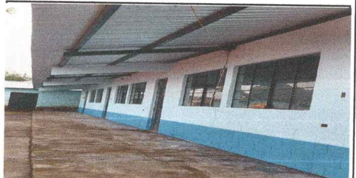
Foto 6: Sustrucción de estructura de metal de ventana, sustitución de vidrios por quebrados y marcos oxidados.
