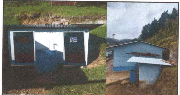
Foto 4: Sustrucción de puertas de servicios sanitarios, cambio de madera a metal.
