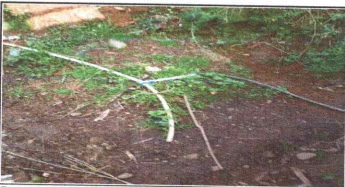
Foto 5: sustitución de tubos de red de agua potable por tubos ya quebrados.
