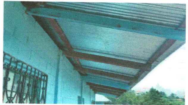
Foto 4: Cambio de cubierta de lamina de aula
