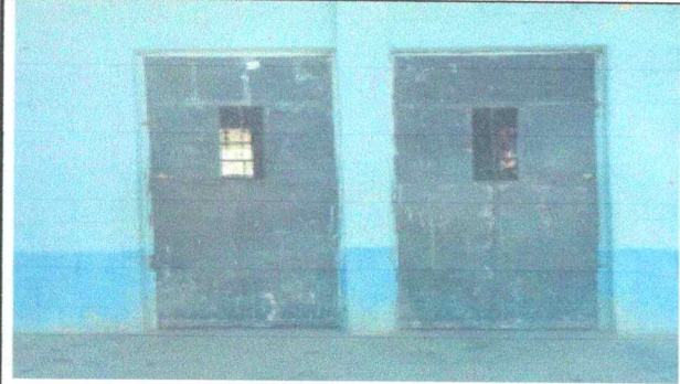
Foto 8: Mantenimientos de puertas
