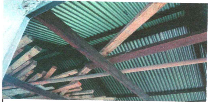
Foto 2: Cambio de estructura de techo para cocina
