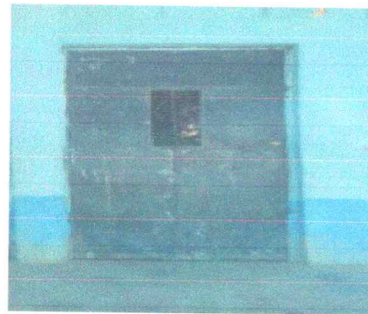
Foto 6: Sustitucion de puerta
