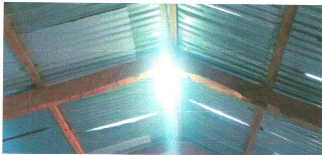
Foto 5: cambio de estructura de techo para el aula.
