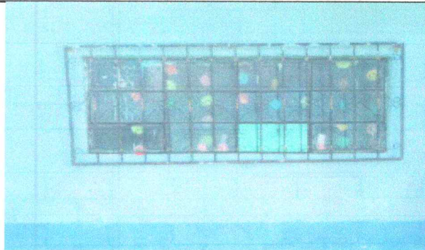
Foto 9: Mantenimientos de balcones
