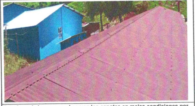
Foto 2: en la imagen se observan los capotes en malas condiciones por tal razon es necesario el cambio de las mismas
