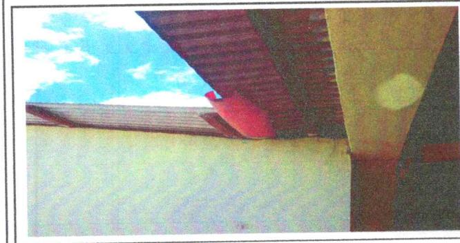
Foto 5: en la imagen se observa que la bajada de agua esta en malas condiciones
