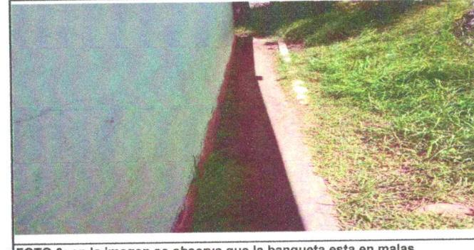
FOTO 6: en la imagen se observa que la banqueta esta en malas condiciones
