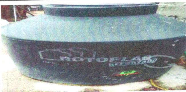
Foto 11: se observa el tinaco para almacenar agua esta en malas condiciones por tal razon es necesario de hacer el cambio.
