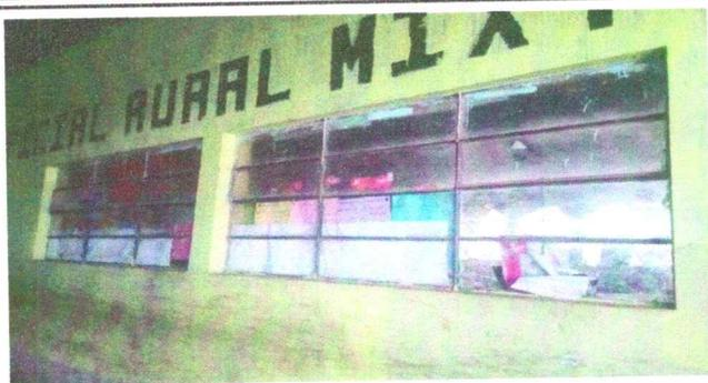
Foto7: se observa la pintura exterior e interior esta en malas condiciones
