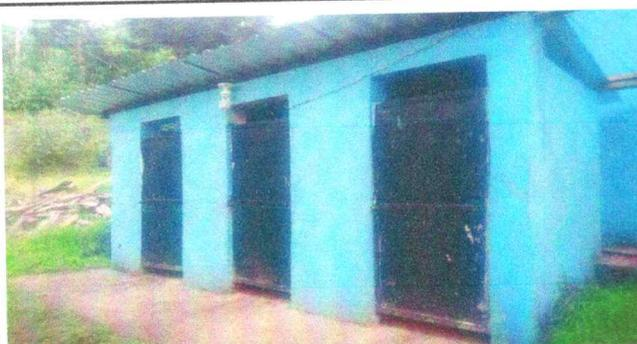
Foto 9: en la imagen se observan las puertas que estan en malas condiciones por tal razon es necesario su mantenimiento
