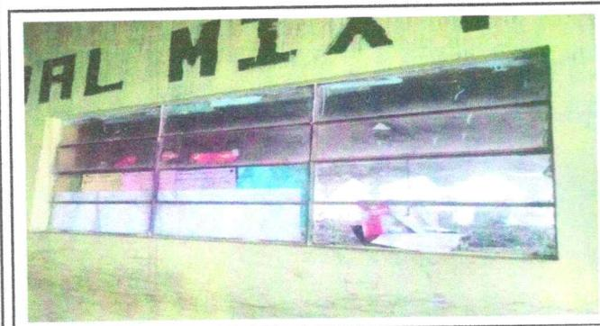
Foto 3: se observa el marco de las ventanas estan en malas condiciones por tal razon es necesario el cambio
