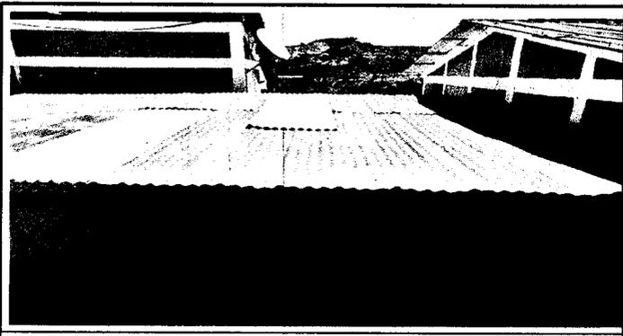
Foto 5: Se cambia el techo de la dirección y su puerta ya que en el tiempo de invierno cae mucha gotera por el deterioro de la misma
