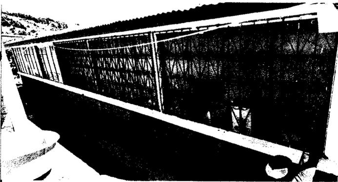
Foto 3: Edificio escolar 1. Se cambia las ventanas del edificio escolar, porque la mayoría esta quebradas y en mal estado.
