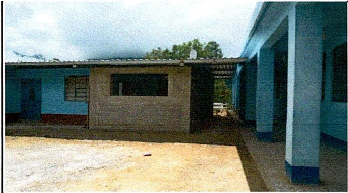
Foto1: Trabajo terminado de ampliación de cocina y techo
