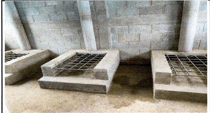
Foto 2: Trabajo terminado de parrilla y chimenea
