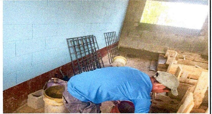
Foto 2: Ejecución de los colocaciones de parrillas y chimenea
