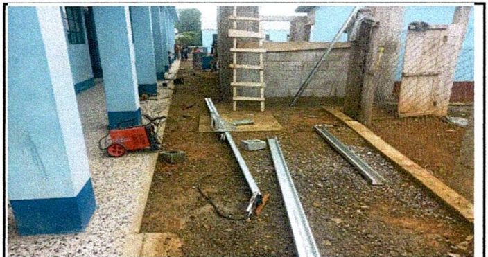
Foto 4: Ejecución de la estructura e instalación de techo.
