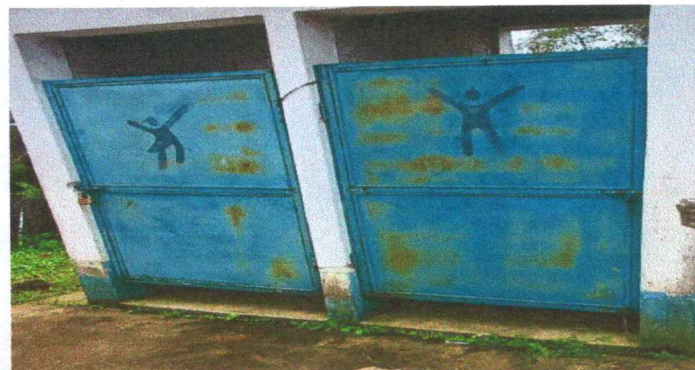
Foto 4: Sustitución de puerta en servicios sanitarios
