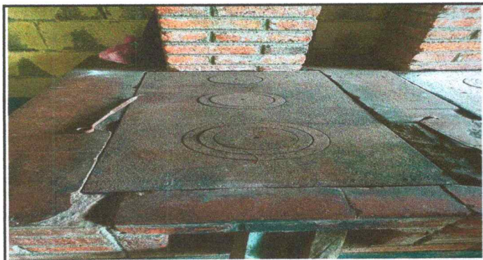
Foto 9: Sustitución de plancha de metal de 3 hornillas
