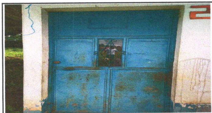
Foto 3: Sustitución de puerta
