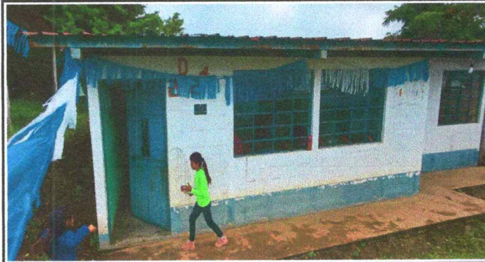
Foto 7 : Pintura en muros exteriores e interiores
