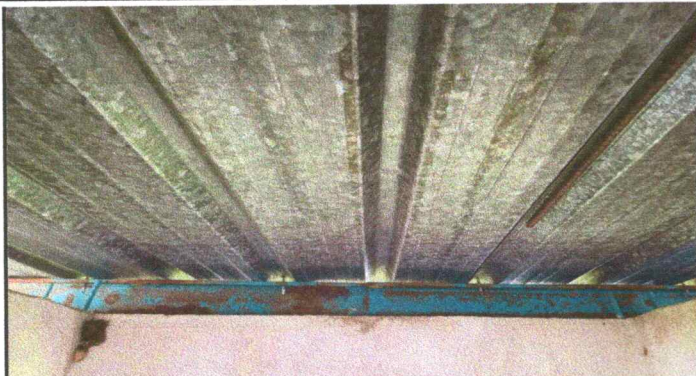
Foto 1: Mantenimiento a estructura de soporte de metal
