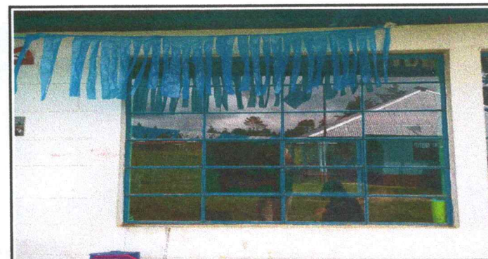
Foto 6: Sustitución de estructura de metal de ventana
