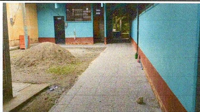
Reparación de piso de torta de concreto, sustituyendo con piso ceramico antideslizante
