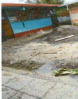
Reparación de piso de torta de concreto, sustituyendo con piso ceramico antidezlizante
