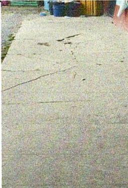
Reparación de piso de torta de concreto, sustituyendo con piso ceramico antidecizante
