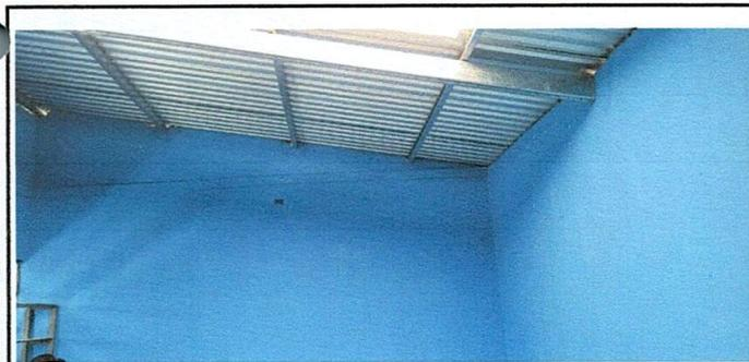
Foto 5. Vigas de madera sustituidas por costaneras
