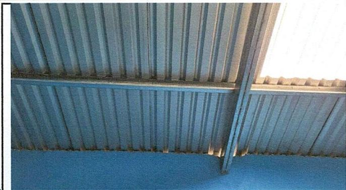
Foto1. Láminas sustituidas
