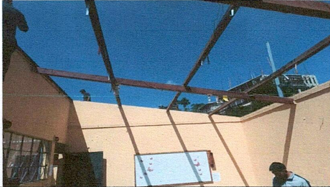
Foto 1. Desmontaje de láminas y vigas de madera
