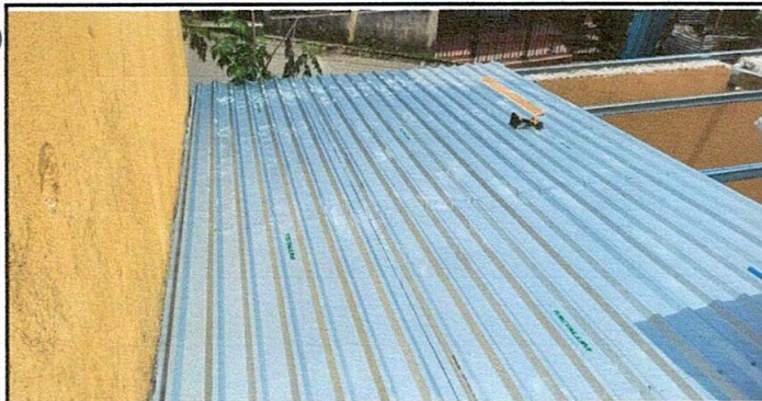
Foto 5. Colocación de láminas troqueladas
