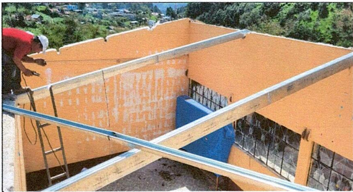
Foto 3. colocación de costaneras
