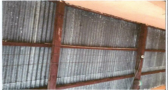
Foto 2: sustitución de costanera de madera.
