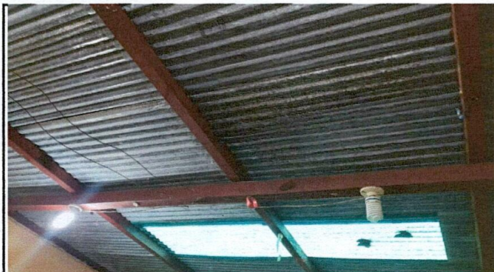
Foto 3. sustitución de cableado eléctrico.
