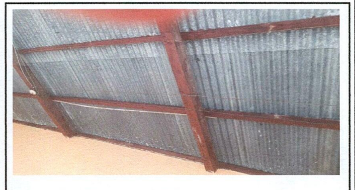
Foto 4. Sustitución de cableado eléctrico
