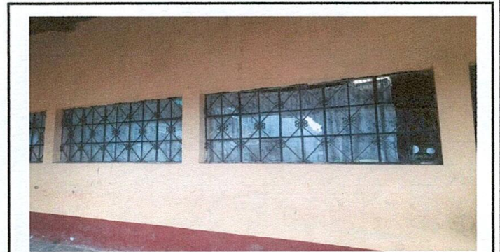
FOTO 6: pintado de estructura interior
