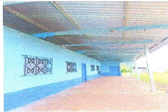
FOTO 4: ESTRUCTURA DE SOPORTE DE METAL INSTALADO
