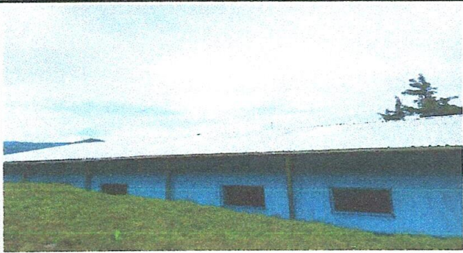
FOTO1: LAMINAS TROQUELADAS INSTALADAS
