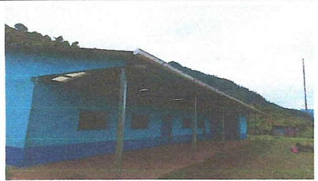
FOTO 2: CANALES DE AGUA PLUVIAL INTALADAS
