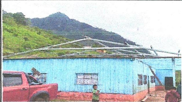
FOTO 4: COLOCACION DE ESTRUCTURA DE SOPORTE DE METAL
