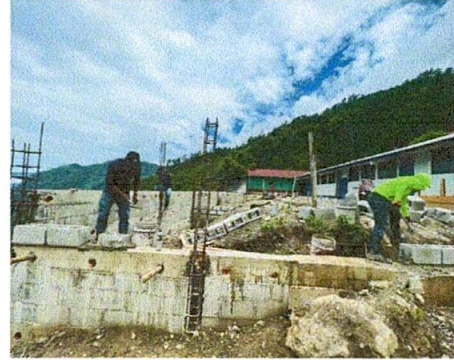
Foto 2: TERMINO DE LA ULTIMA SOLERA DEL MURO DE CONTENCIÓN
