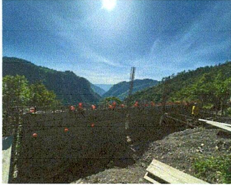
Foto 1: COLOCACIÓN DE HIERROS DE LA ULTIMA COLUMA 80% DE AVANCE
