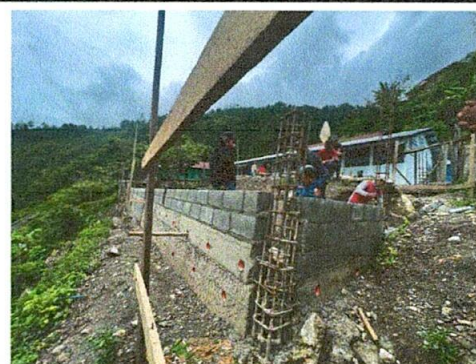
Foto 4: COLOCACIÓN DE BLOCK PARA MURO DE CONTENCIÓN
