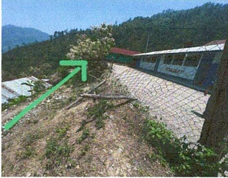
Foto 1: Reparación de muro de contención
