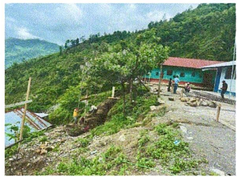
Foto 4: Arranque del muro de contención
