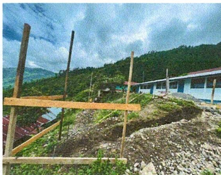
Foto 3: Colocación de escuadra y mediciones del área
