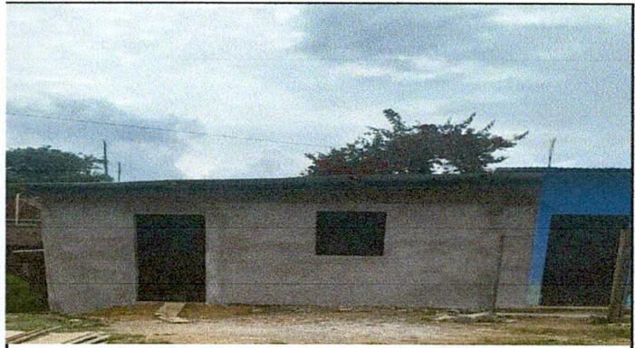
FOTO: 2 MEJORAMIENTO PARED DE COCINA
