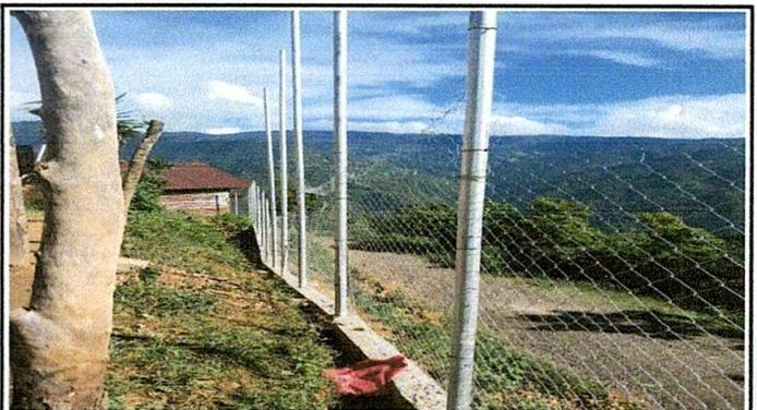
Foto 4: Reparación de muro perimetral de block con tubo hg y malla galvanizada, culminado.
