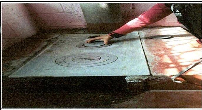
Foto 5: Sustitución de plancha de metal de 3 hornillas, culminado.
