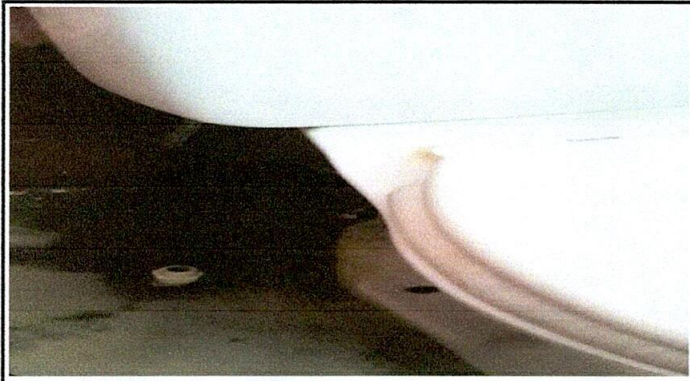
Foto 1: Sustitución de accesorios inodoro en proceso.
