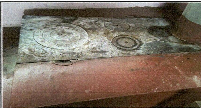
Foto 5: Sustitución de plancha de metal de 3 hornillas
