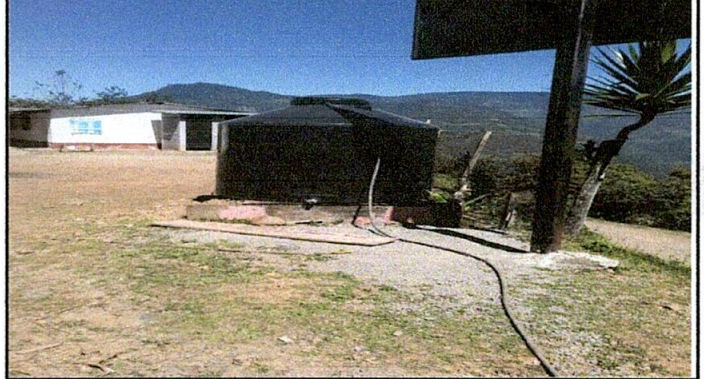
Foto 2: Sustitución de tubería línea principal
