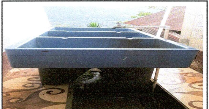
Foto 6: Sustitución de pila de cemento de dos lavadero
