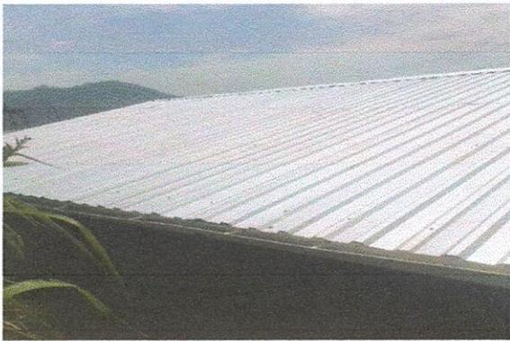
Foto 3: Sustitución de lámina, por lámina troquelada
