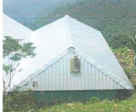
Foto 2: Sustitución de lámina, por lámina troquelada
