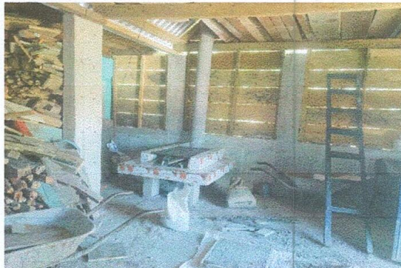
Foto 1: Sustitución de piso de torta de concreto
