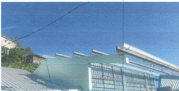
Foto 3: Sustitución de lámina, por lámina troquelada
