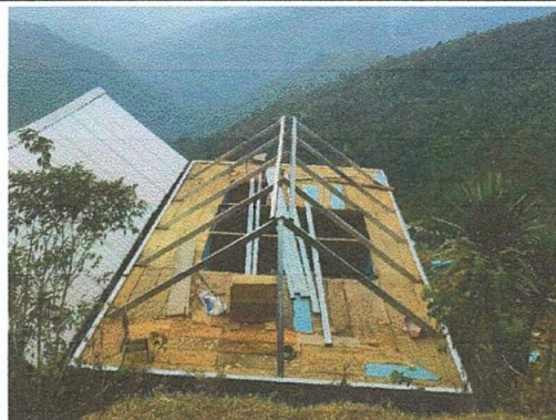
Foto 2: Sustitución de lámina, por lámina troquelada
