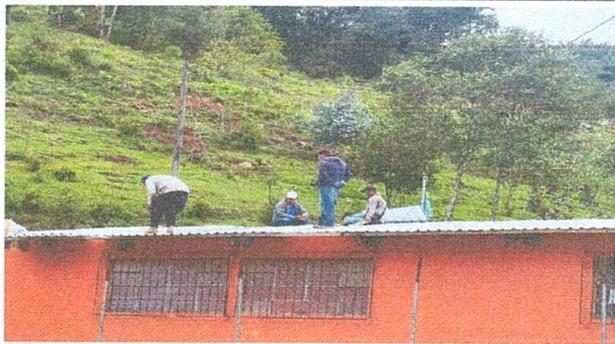
Foto 4: colocación de laminas troqueladas
