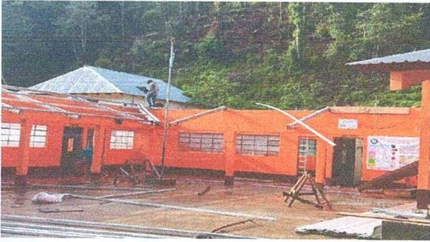
Foto 1: colocación de costaneras de metal
