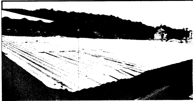
Foto 1: lámina en malas condiciones
