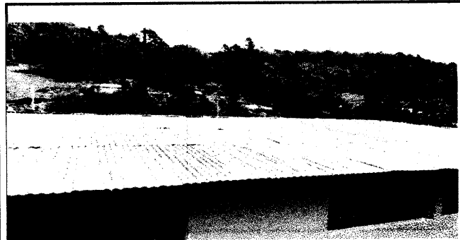
Foto 3: tragaluz en malas condiciones
