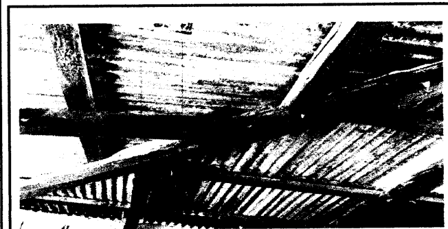
Foto 5: estructura de madera en malas condiciones
