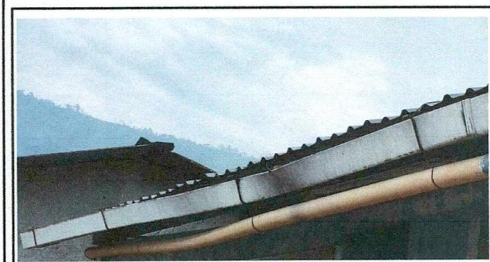
Foto 3: instalación de reforzamiento de costanera
