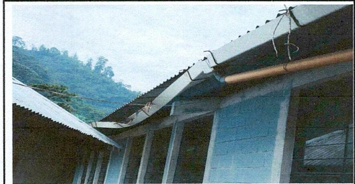
Foto 1: Sustrucción de retenedor de costaneras.
