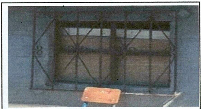
Foto 4: Sustrucción de balcones
