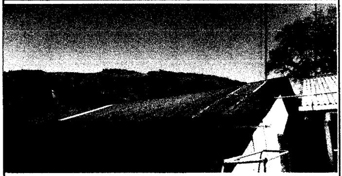
Foto 2: sustitución de laminas oxidadas y con agujeros.
