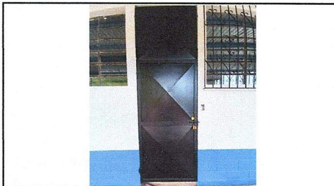
Foto 3: Instalación y pintado de puertas satisfactoriamente.
