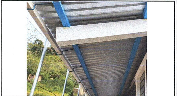
Foto 2: Instalación satisfactoria de canales para agua pluvial.
