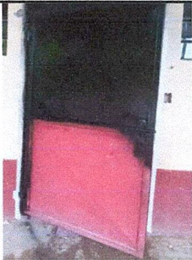
Foto 3: Reparación de y pintado de puertas de metal.
