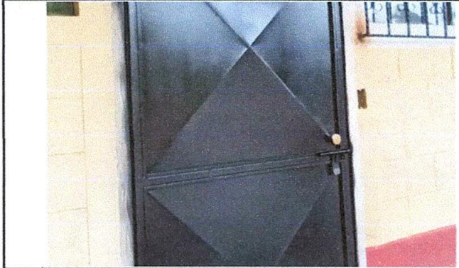
Foto 2: Instalación de nuevas chapas para las puertas.
