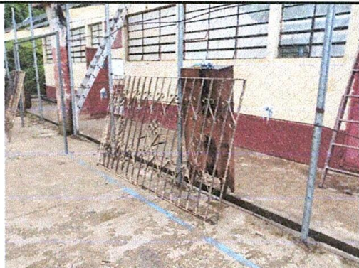
Foto 4: Reparación e instalación de valcones para las ventanas.
