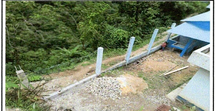
Foto 4: Reparación de muro perimetral de block con tubo hg y malla galvanizada, soleras intermedias y columnas finalizado.
