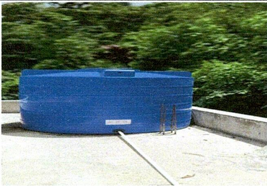
Foto 3: Sustitución depósito de agua finalizado
