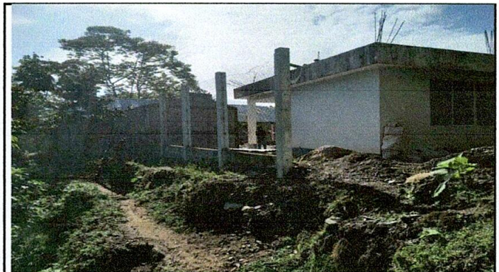
Foto 4: Reparación de muro perimetral de block con tubo hg y malla galvanizada, soleras intermedias y columnas en proceso.
