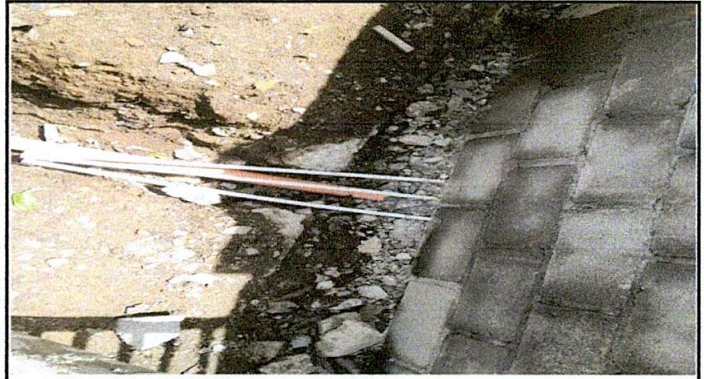
Foto 2: Sustitución de tubería de agua línea principal. Sustitución llave de chorro en proceso.
