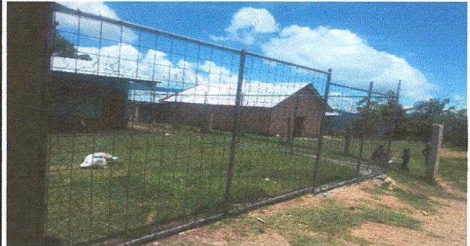
Foto 2: colocacion de electromalla
