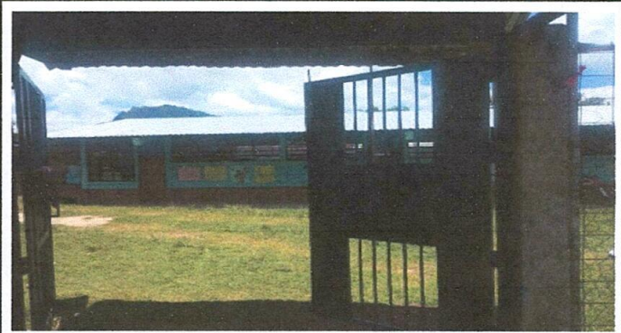
Foto 4: colocacion de porton de metal
