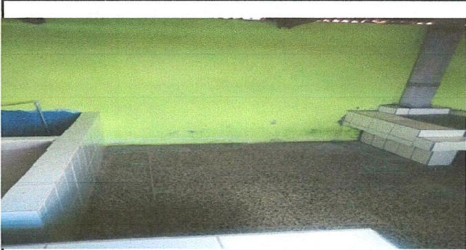
Foto 1: colocacion de plancha con chimenea y azulejos
