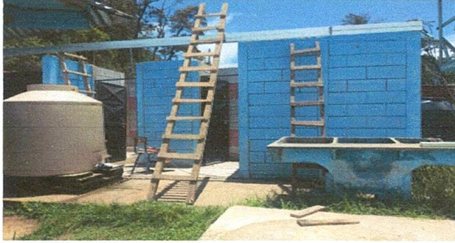
Foto1: Arreglo de costaneras para techo de baños
