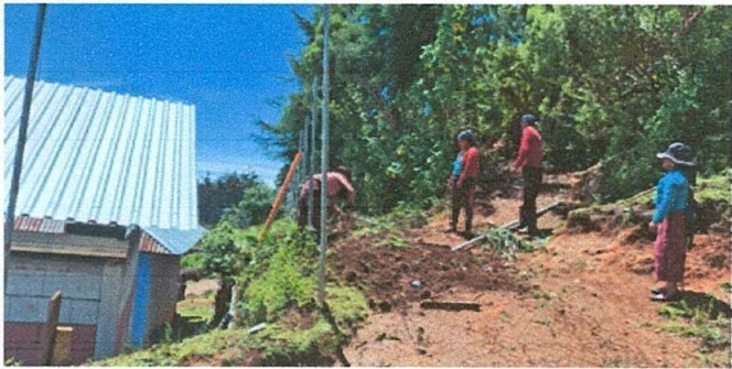
Foto 5: cambio de malla por electromalla
