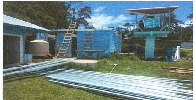
Foto 2: cambio de puesta de madera de cocina por metal
