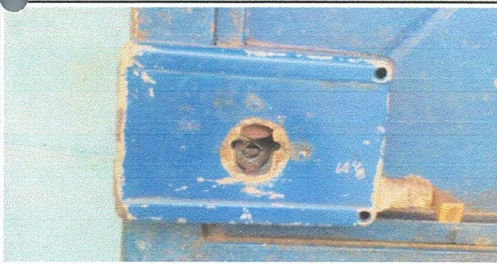
Foto 5: Cambio de chapas para puertas de la escuela
