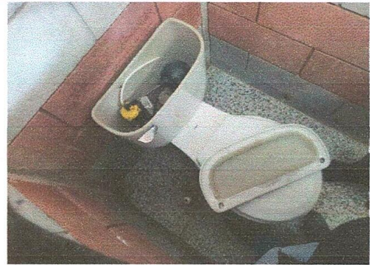
Foto 4: Instalación de nuevos accesorios para tazas
