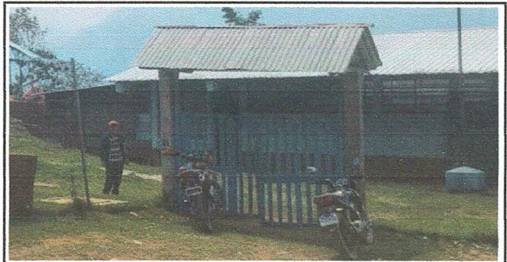
Foto 6: Sustitución de puerta de madera por portón
