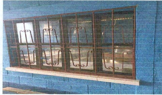
Foto 2: REPARADO LOS VALCONES
