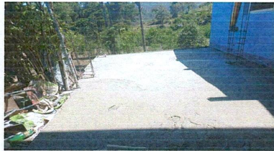
Foto 4: REPARADO EL PISO DE BODEGA
