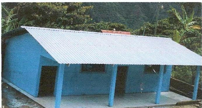
Foto 1: Sustitución de lámina, por lámina troquelada
