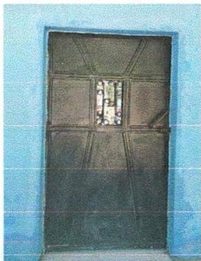
Foto 3: Sustitución de puerta de madera, por puerta de metal
