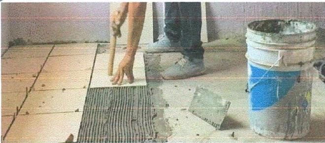
Foto 5: Sustitución de piso de concreto de aula por piso antideslizante
