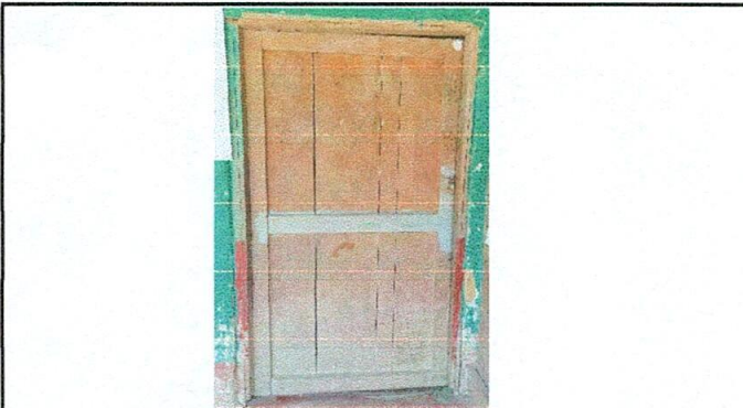
Foto 3: Sustitución de puerta de madera, por puerta de metal
