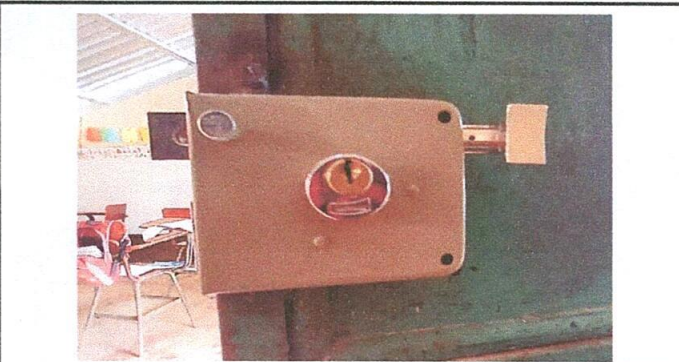
Foto 5: chapa de puertas de metal instalada.
