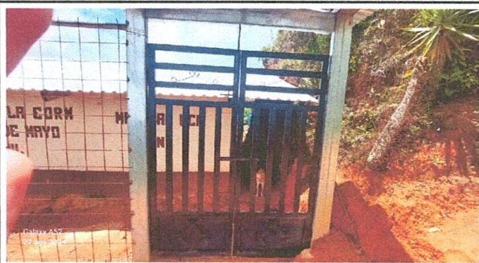
Foto 3: portón instalado y sustituye a puerta de madera.
