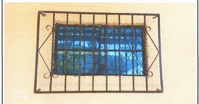
Foto 2: ventana con marco de metal y vidrios nuevos instalado.
