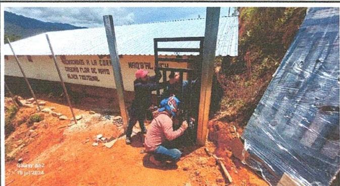
Foto 3: colocación de portón que sustituye a puerta de madera.
