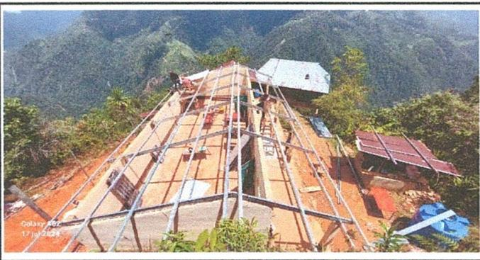
Foto 6: colocación estructura de techo con constaneras sustituyendo la estructura de medera.
