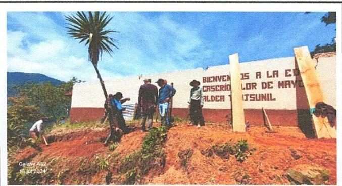
Foto 4: realizando sanja para la colocación de tubos galvanizados para la colocación de electromalla.
