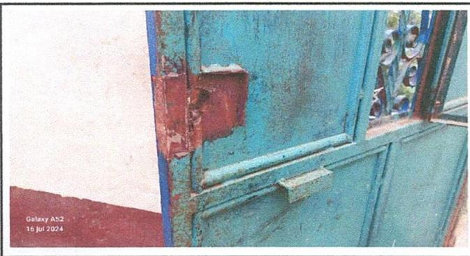
Foto 5: desinstalación de chapa de puerta de metal para instalar nueva chapa.
