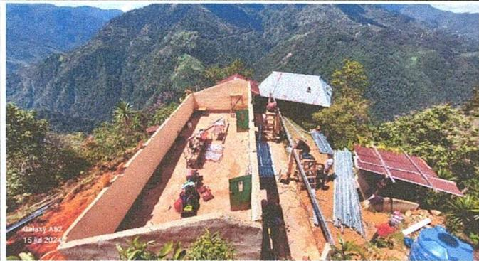
Foto1: desmantelación del techo de lámina para colocar techo con lámina troquelada.
