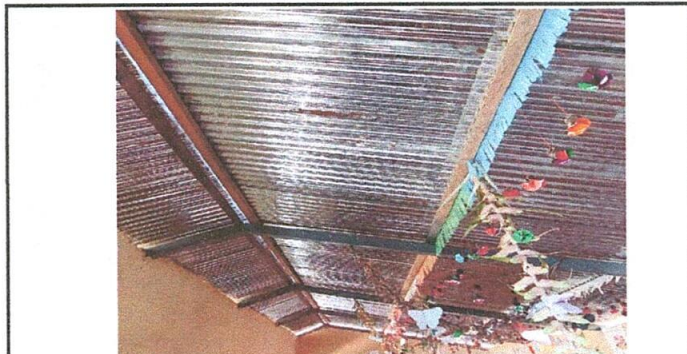
Foto 6. cambio de estructura de techo de madera por estructura de metal.
