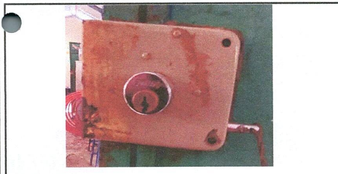
Foto 5. cambio de chapa de puerta de metal.
