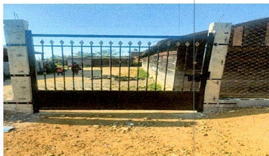
Foto 5: FINALIAZACIÓN DE LA INSTALACIÓN DEL PUERTÓN DE METAL.
