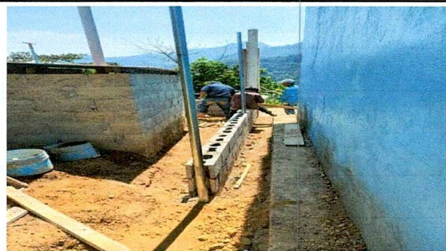
Foto 3: CONSTRUCCIÓN DE MURO PERIMETRAL DE BLOCK.
