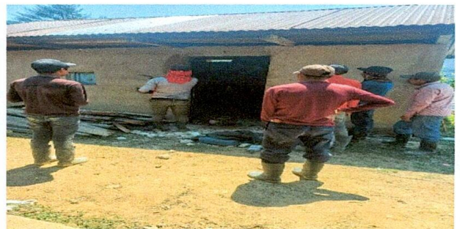
Foto 6: INSTALACIÓN DE PUERTA DE METAL.
