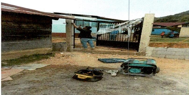
Foto 5: INSTALACIÓN DEL PUERTÓN DE METAL.
