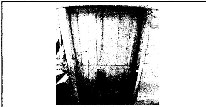
SUSTITUCIÓN DE PUERTA
