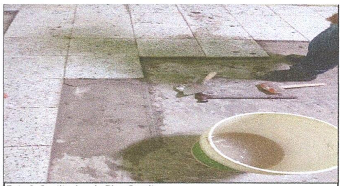
Foto 6: Sustitucion de Piso Granito
