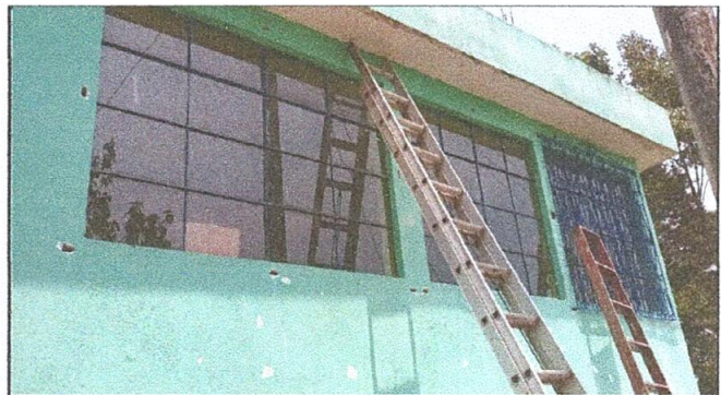
Foto 4: Instalacion de Balcones
