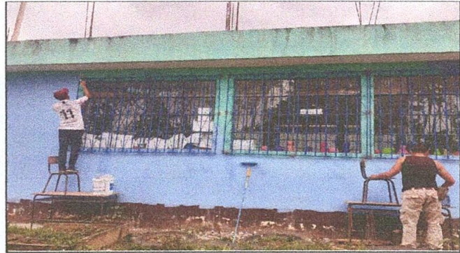
Foto 2: Aplicación de Pintura
