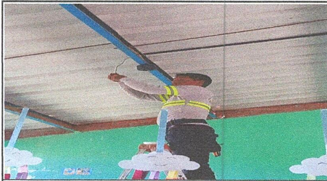
Foto1: Sustitucion de Plafoneras
