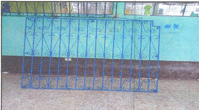
Foto 3: Instalacion de Balcones
