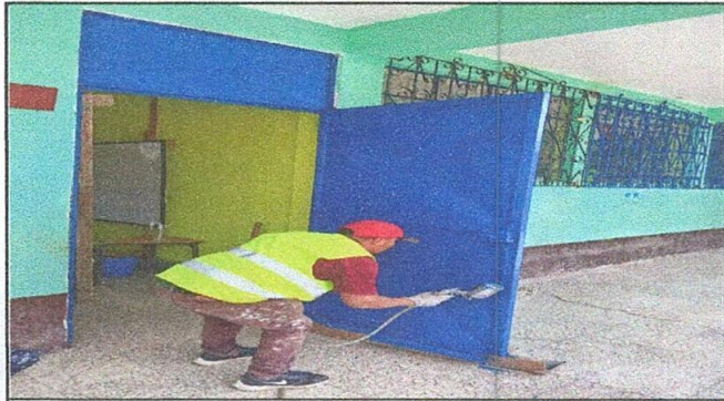
Foto1: Mantenimiento de puertas de metal (aplicación de Pinturas)
