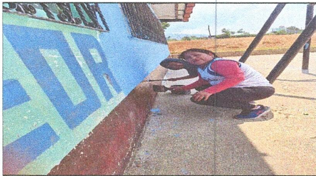
Foto 3: Aplicación de Pintura en Exteriores
