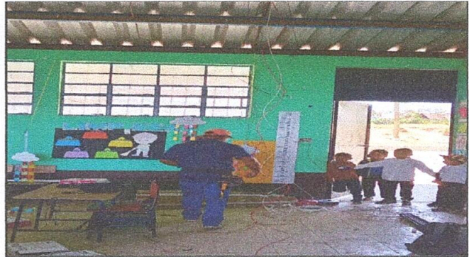
Foto 2: Reparacion de Cableado Electrico
