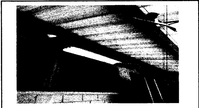
FOTO 4: SUSTITUCION DE PLAFONERAS
